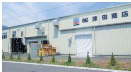
〈海岸沿いから移転し再建された津田商店（釜石市）〉
